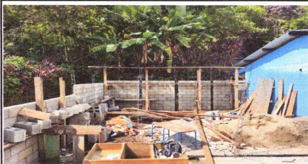
Foto 1: Sustitución de pared de tablas por block de cocina
