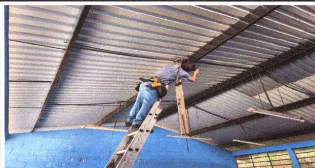
Foto 2: Sustitución de cableado y lamparas
